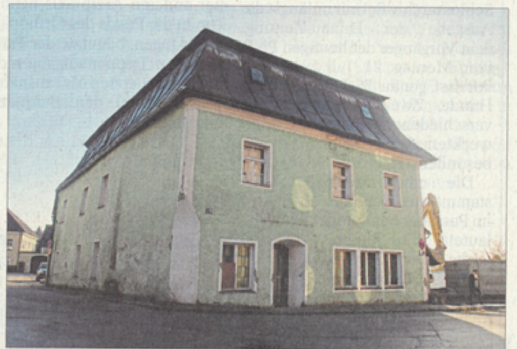
Das Ortinger-Haus von außen. Aktuell ist es eingerüstet und wird umgebaut. Das Dach war der Hauptgrund, warum das Gebäude an der Ecke Abtei-/Kolpingstraße einst unter Denkmalschutz gestellt wurde.
